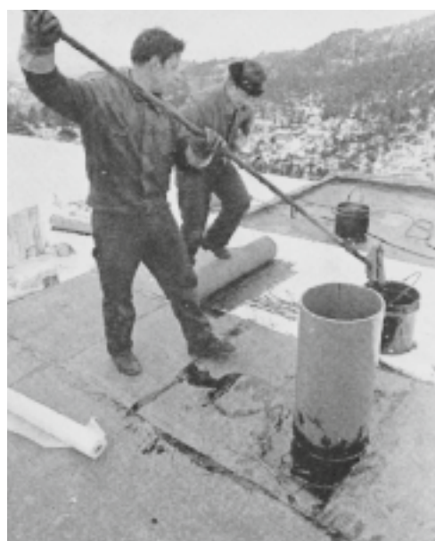
Taktekkere i arbeid.
