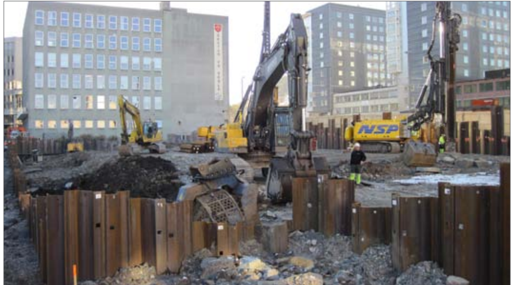
Grunnarbeid til et nytt moderne psykiatrisk sykehus, i gang ved Danmarks plass.
