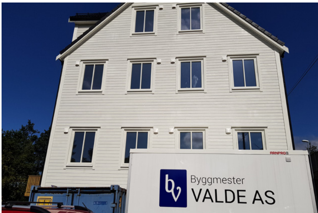
I Inndalsveien rehabiliterer Byggmester Valde denne boligen.
